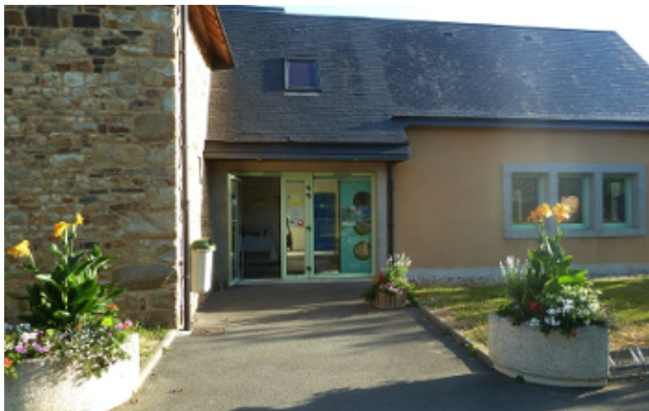
Bibliothèque Intercommunale de Ducey-Les Chéris
